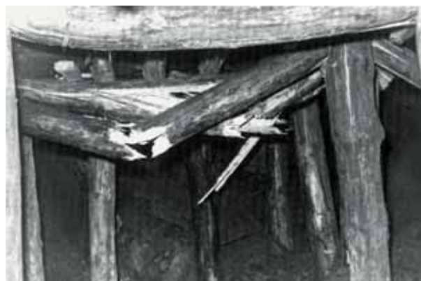
Effondrement d'une galerie souterraine 40
